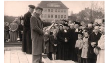
Grundsteinlegung der Kirche, im Hintergrund die ehemalige Landwirtschaftsschule, später Hotel Europa
